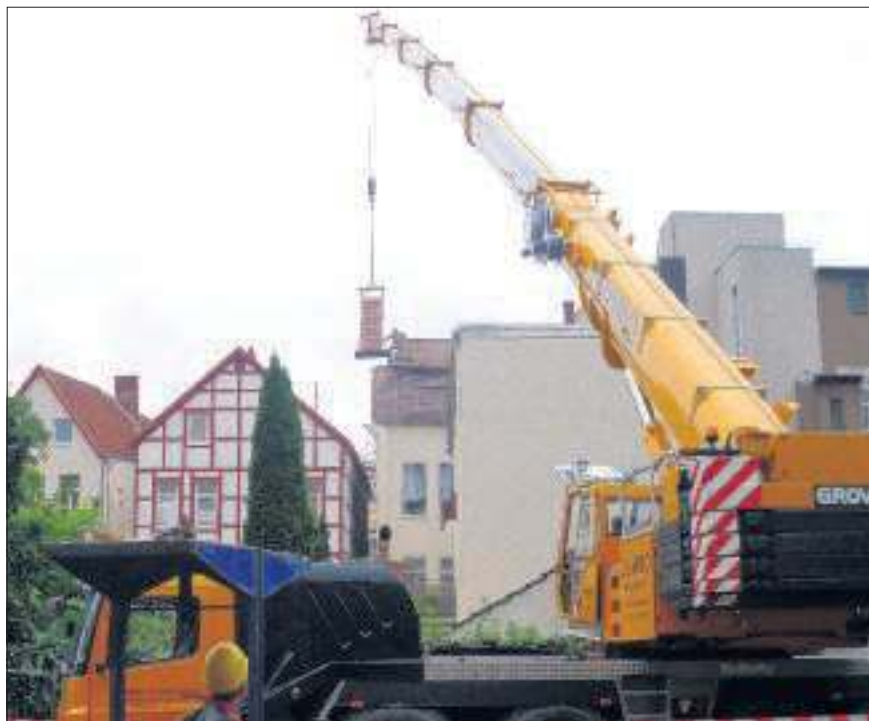
Maßarbeit: Am Giebel des Hauses Bäckerstraße 18 nehmen die Maurer den Schornsteinkopf in Empfang. MT-Fotos: Langenkämper
