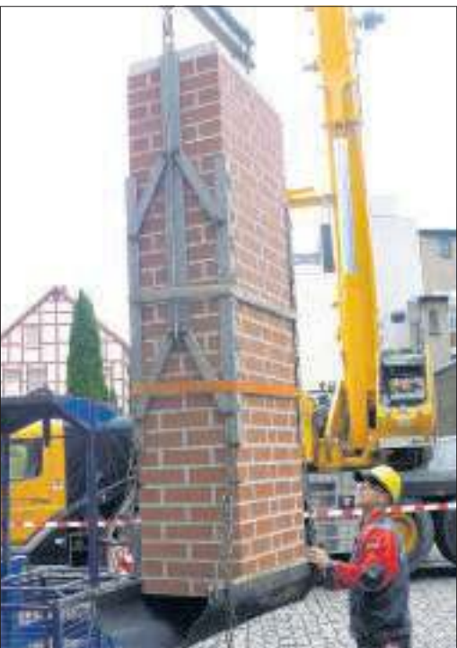
Auf geht's: Der Kran hebt das Bauteil hinterm Rathaus an. Tobias Althoff schaut hinterher.
